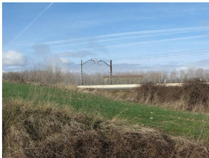
Vistas de la fábrica de Biomasa y la ampliación del EDAR, localizadas justo al norte del ámbito del sector y el cercano yacimiento arqueológico de "Carrandrinal", desde el noreste
