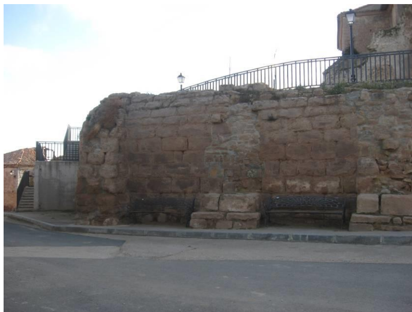
Zona meridional del sector SE-5. El BIC y yacimiento arqueológico de la "Torre de los Varona", en la localidad de Cameno
